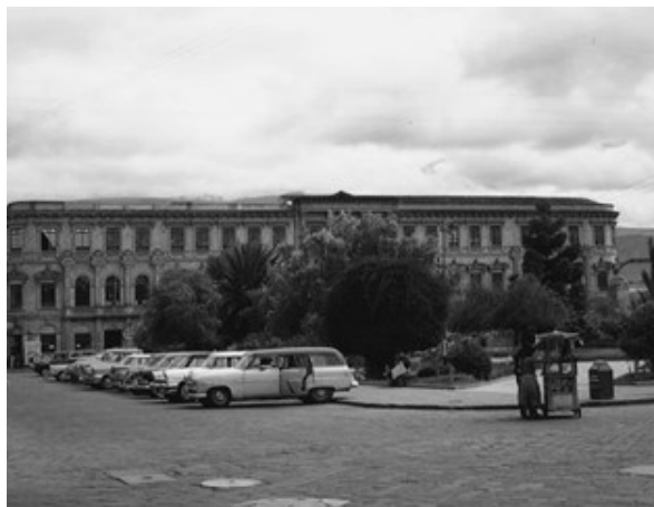
Figura 21 UP2 - Exterior del edificio Colegio Bolivar
