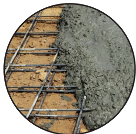
Losa autoportante (cubiertas inclinadas)
