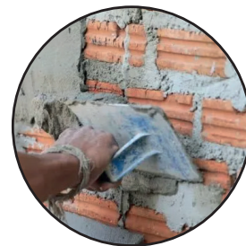
Mampostería de ladrillo con enlucido
