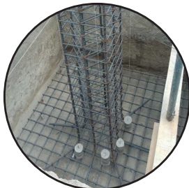
Estructura acero y hormigón armado
