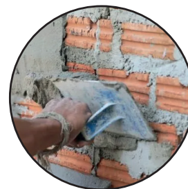
Mampostería de ladrillo con enlucido
