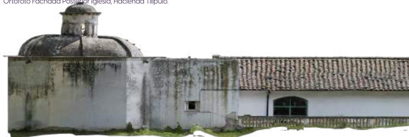
Figura 59. Ortofoto Fachada Posterior Iglesia, Hacienda Tilipulo.
