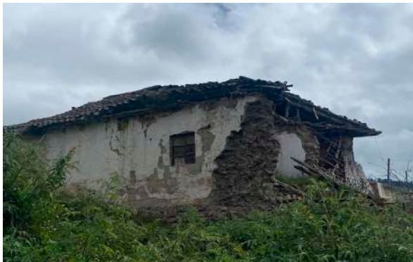
Figura 16. Vivienda vernácula Barrio San Francisco de Cullitagua
