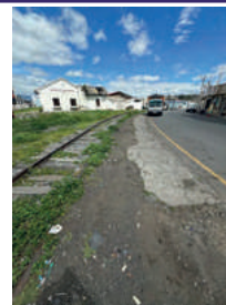
Fotografía 5. Aceras incompletas, crecimiento de maleza.
