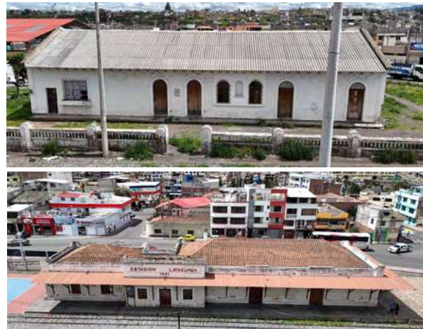
Figura72. Fotografía aérea campamento de sección N°37
