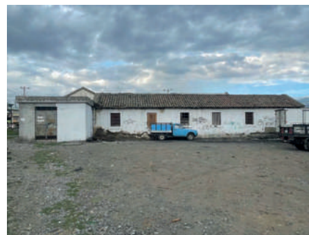
BODEGA DE CAMPAMENTO DE SECCIÓN
