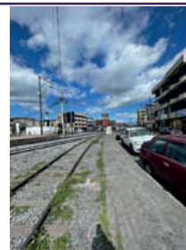
Fotografía 4. Aceras deterioradas y angostas, estacionamientos
