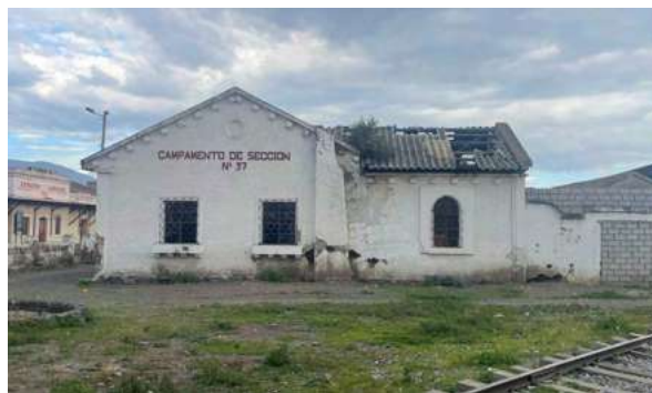
Figura66. Fachada norte del Campamento de Sección N° 37
