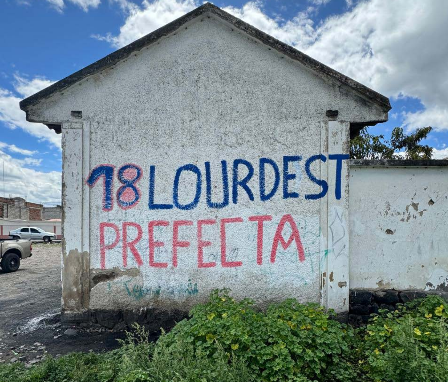
Figura85. Bloque C - Bodega de servicio del campamento de Sección N°37
