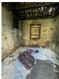
Fotografía 1. Desgaste - antrópicas - Desprendimiento
