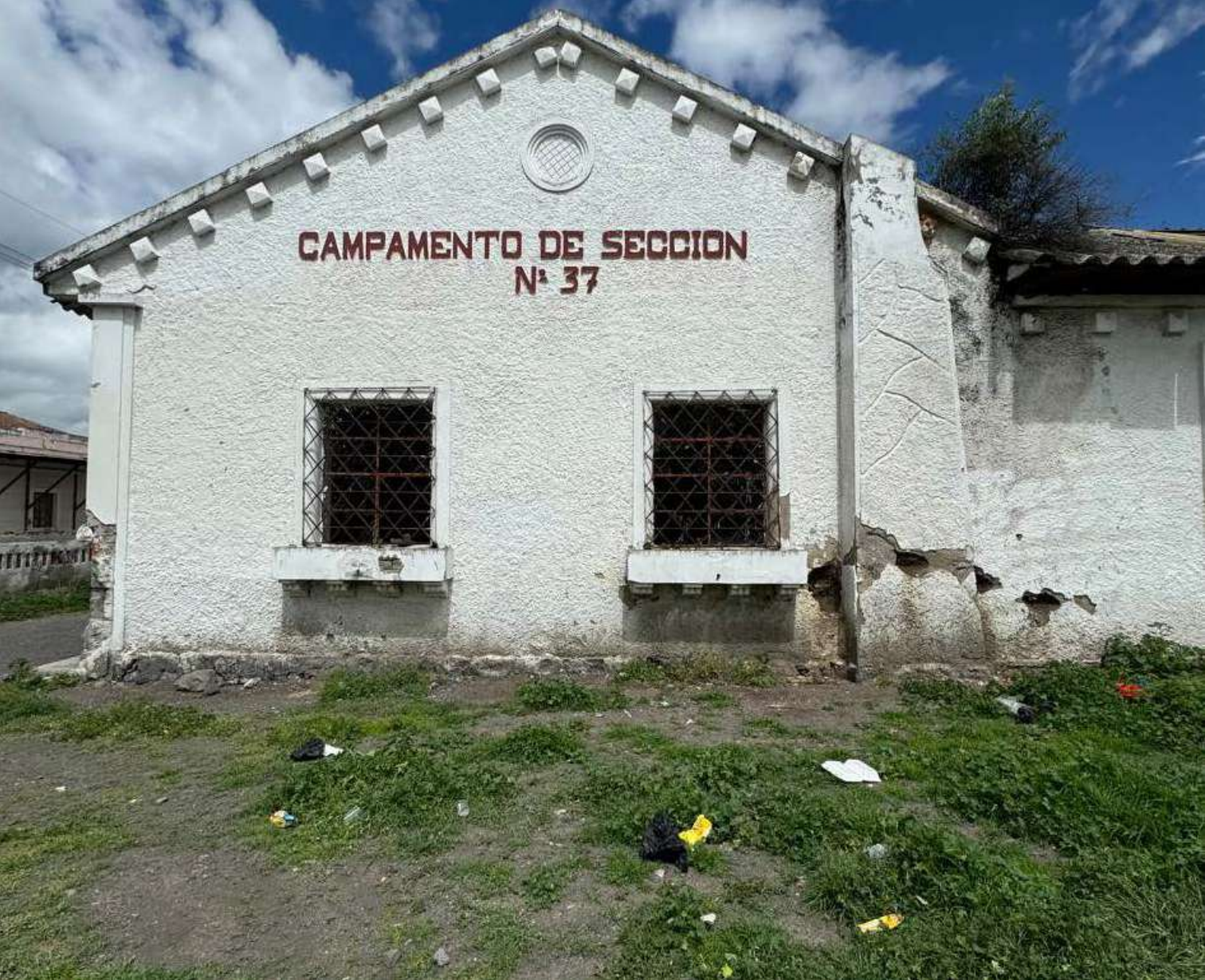
Figura84. Bloque B - Campamento de Sección N°37
