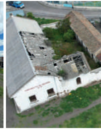
Fotografía 6. Deformación cubierta
