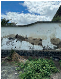
Fotografía 1. Grietas Desprendimiento
