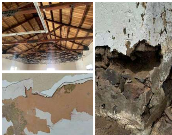
Figura76. Fotografía materiales constructivos.
