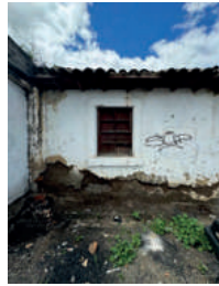
Fotografía 2. Grieta Desprendimiento
