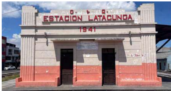
Figura65. Fachada norte de la Estación Latacunga.
