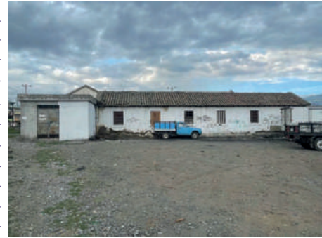
BODEGA DE CAMPAMENTO DE SECCIÓN
