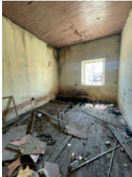
Fotografía 1. Apolillado -Deformaciones Desgaste
