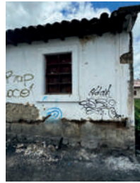
Fotografía 3. Grieta Desprendimiento
