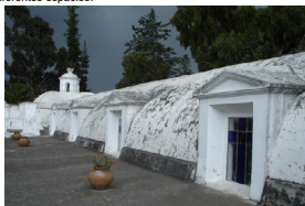
Descripción:Vista de la bóveda de la iglesia en la que se aprecian los lunetos.
