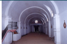
Descripción:La iglesia en su interior presenta una sola nave definida por una bóveda de cañón construida en piedra pómez al igual que el resto de la edificación.
