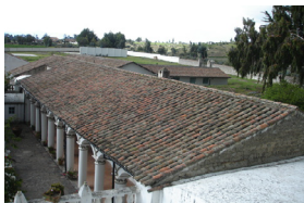
Descripción:Detalle de la cubierta en teja
