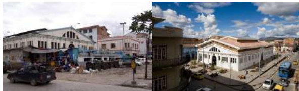
Figura 01. Rehabilitación Mercado 9 de Octubre - Cuenca
