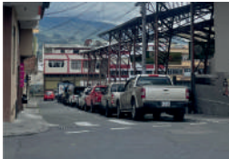
Figura 45. Estado de vías
