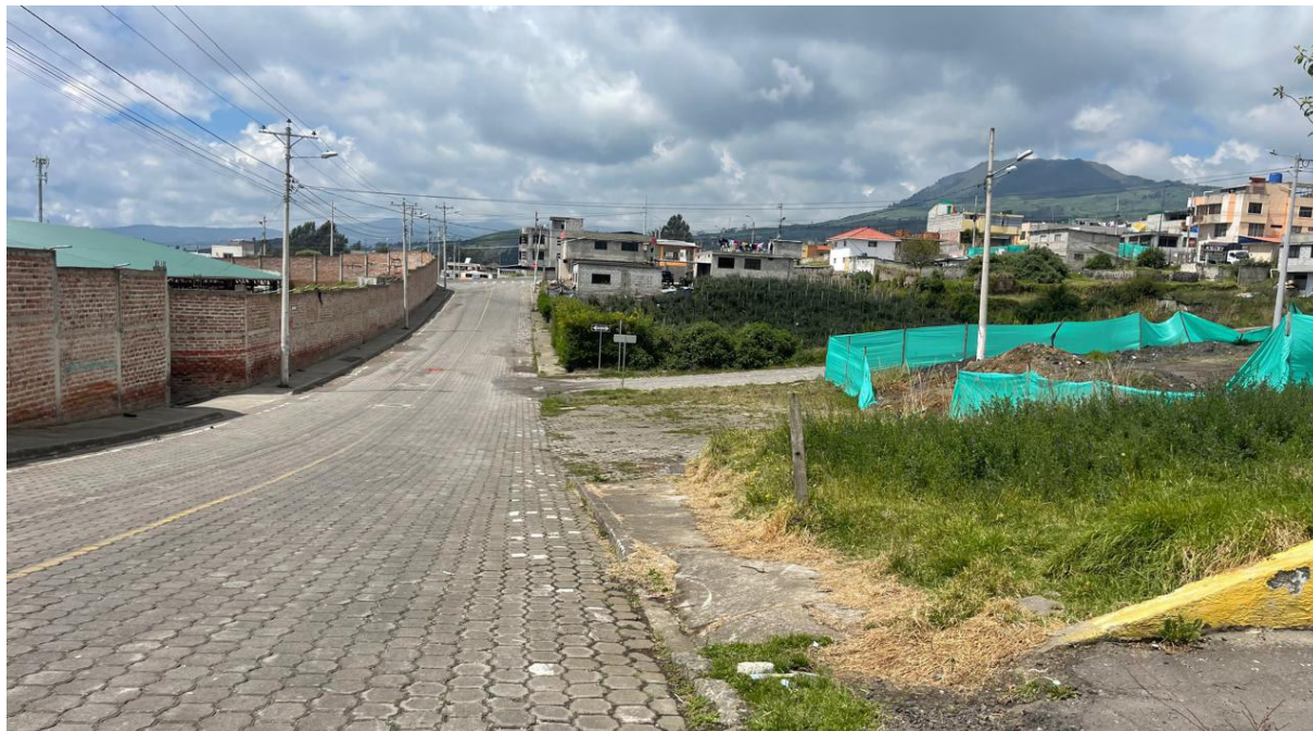
Nota O3. Estado actual de la Calle Amazonas y la zona adyacente al Estadio Municipal de Tisaleo. Imagen tomada por el autor.
