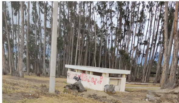
FIGURA.04. DETERIORO DEL PARQUE TROYA
