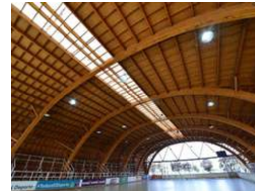
Figura 4. Elementos curvos de madera laminada Fuente: (Espinoza. 2021).
