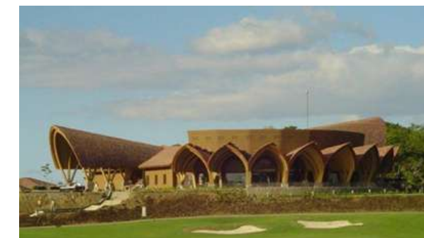
Figura 10. Edificaciones formadas por vigas curvas Fuente: (Gonzales. 2022).
