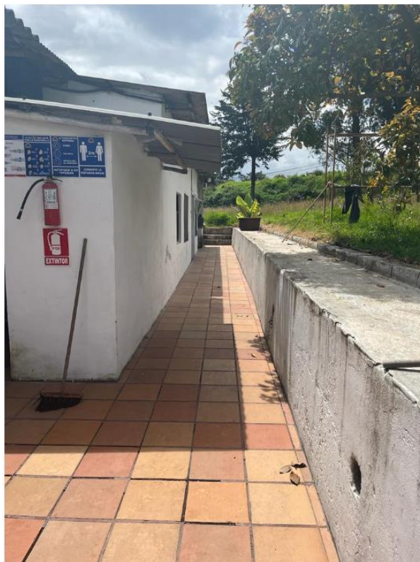
Figura 6 Pasillo de tránsito entre área de producción y almacenamiento
