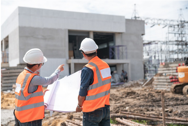
Fig. 7 Planificación de la obra
