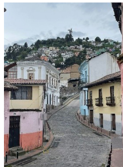
Figura 11. Ciudad de Quito, edificaciones en mal estado y variación de colores Fotografía. Elaboración Propia (2023)
