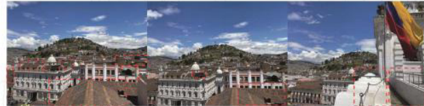
Mirador Iglesia de San Francisco Falta de mantenimiento Mal estado de quinta fachada
