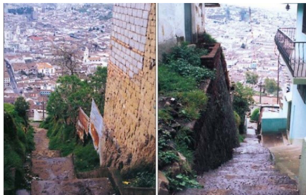
Figura 48. Accesos en mal estado Fotografía. Recuperado de Municipio del Distrito Metropolitano de Quito (2002)
