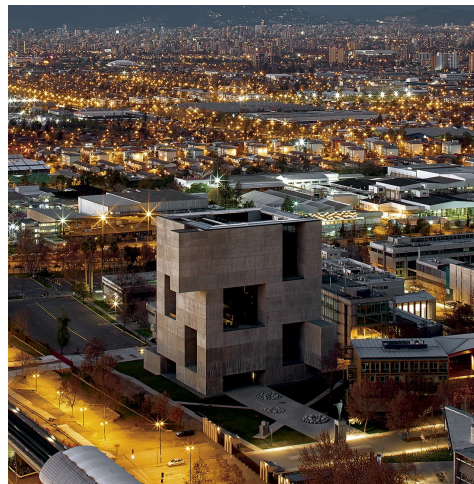
Imagen18. Centro de Innovación UC Fuente: Plataforma Arquitectura
