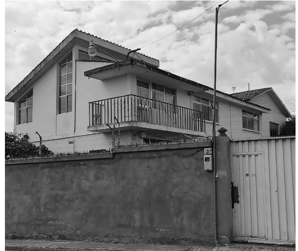
Figura 43. Lateral izquierda vivienda 1980.
