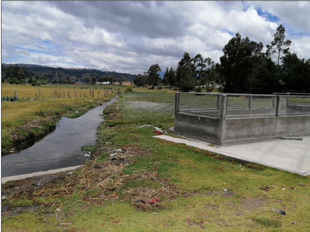
Figura 14. Canal de acequia
