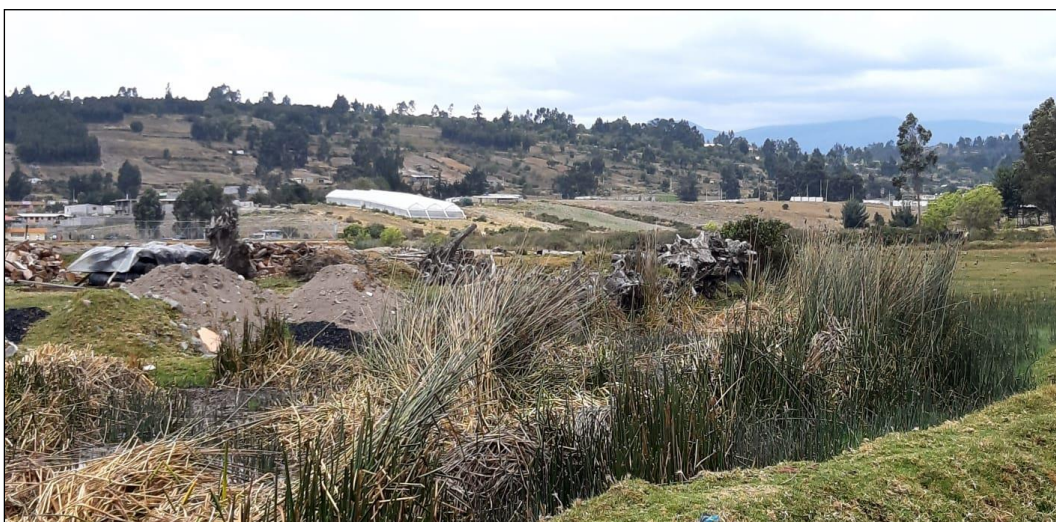
Figura 10. Residuos o escombros de la construcción
