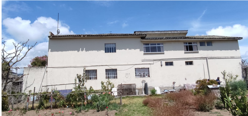
Figura 49. Fachada Posterior orientación sureste, vivienda 1980 (cod. v.10)
