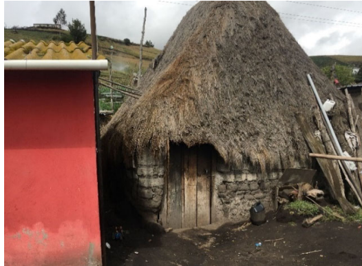
Figura 53. Cubierta de viviendas
