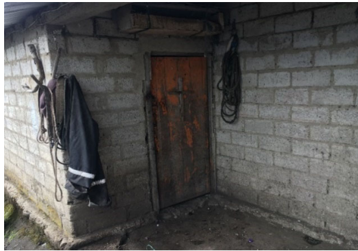
Figura 46. Cimentación de viviendas
