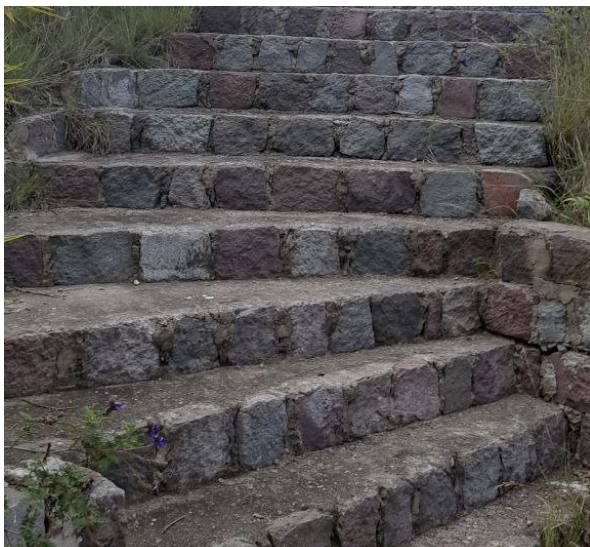
Fig.47. Escaleras con sillares de piedra
