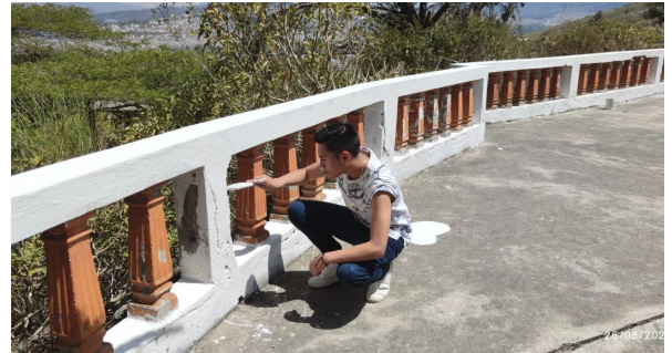
Fig.72. Pintura de Balaustradas
