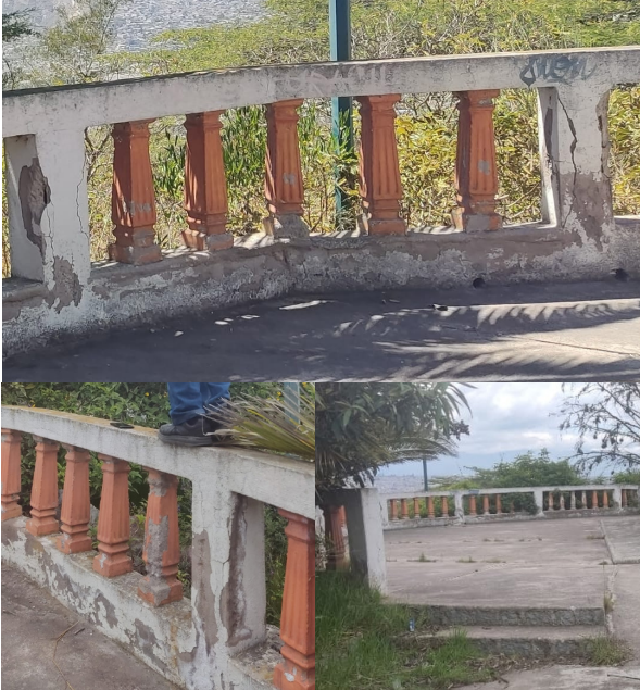
Fig.74. Balastradas antes de la minga
