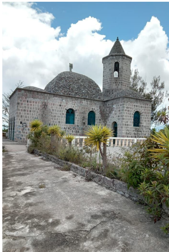
Fig.05. Fachada lateral de la Capilla del Mirador
