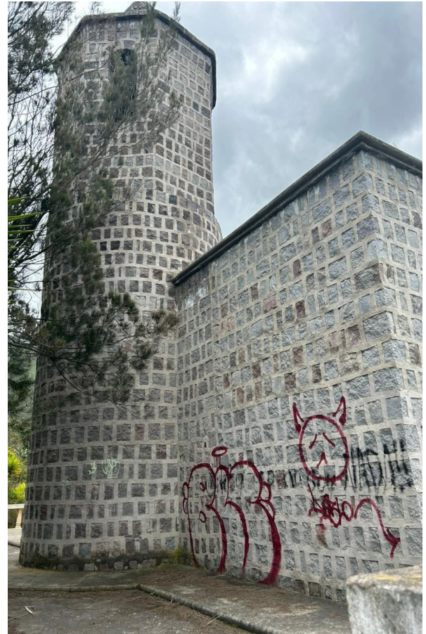
Fig.02. Fachada posterior de la Capilla del Mirador de la Rosa Mística
