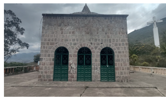
Descripción de la fotografía: Fachadas lateral y frontal de la Capilla
