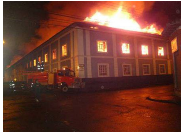
Figura 3 Incendio en el Colegio San Vicente de Paul
