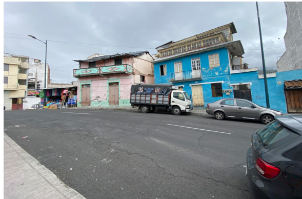
Fig.38. Viviendas en mal estado,sector La Merced.
