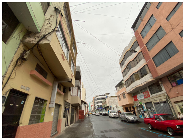
Fig.37. Cableado mal colocado,sector La Merced.
