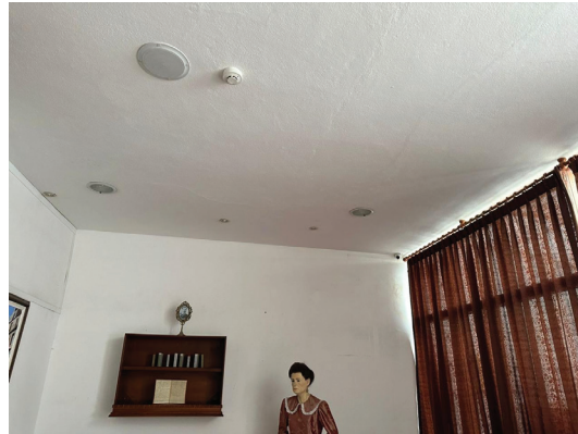
Fig. 05. Espacio interno 1 casa de Juan Montalvo
