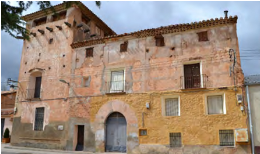
Figura 9. Tapia singular reforzada con brenclas y mampuestos
