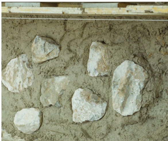
Figura 10. Tapia de hormigón de cal
