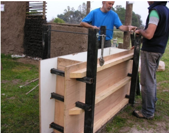
Figura 2. Muro de Tapia.
