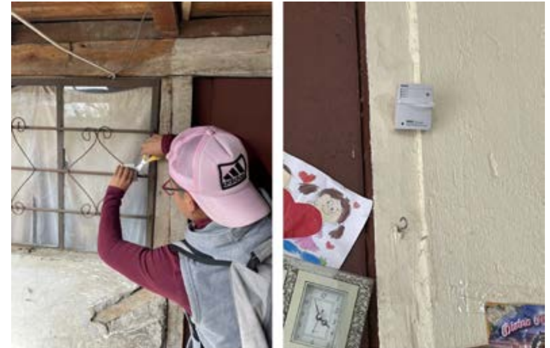
Figura 14. Colocación de dispositivos externos
