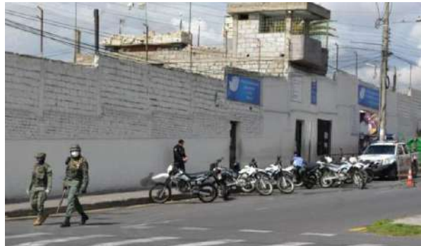
Fig.02. Vista Exterior CRS Ambato
