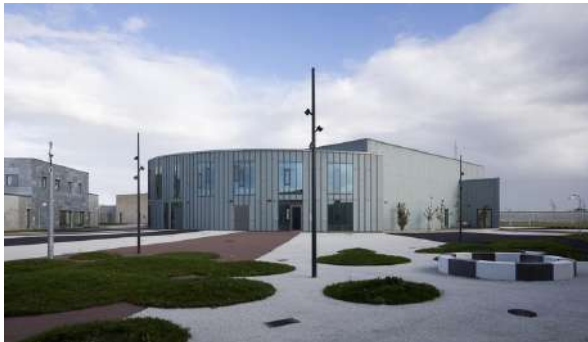
Fig.37. Vista desde el interior de la zona de rehabilitación de Storstrom
