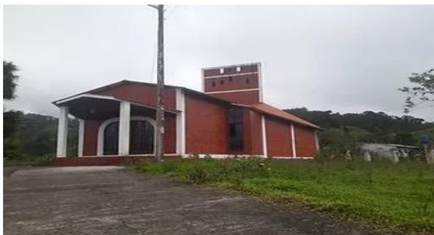
Fuente: Iglesia de “S.F.P”.GAD Las Pampas Elaborado por: Laidy Pilatasig.
