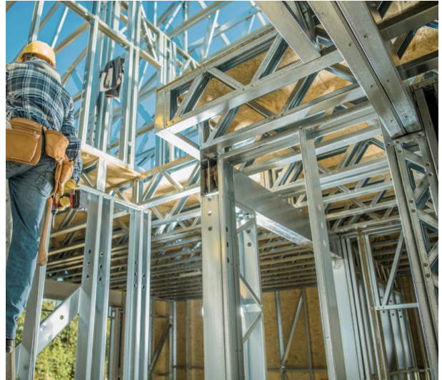
Fig 34. Construcción de Tabiquerías con Drywall Fuente. (Instituto Celsius, 2018)
