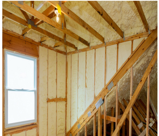
Fig 47. Construcción y Aislante de Poliuretano Fuente. (REITEMAN, 2019)
