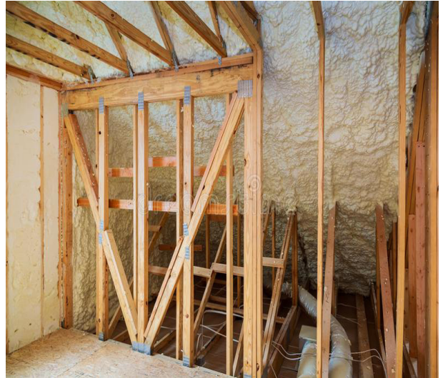
Fig 46. Construcción de Tabiquerías con Aislante de Poliuretano Fuente. (REITEMAN, 2019)
