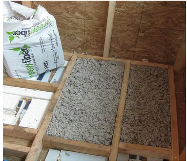
Fig 50. Construcción con Aislante de Celulosa Fuente. (Ferro Ambiental, 2020)
