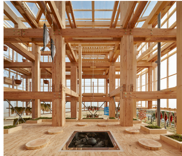
Fig 43. Construcción en Estructura Madera Fuente. (Kuma & Associates, 2014)
