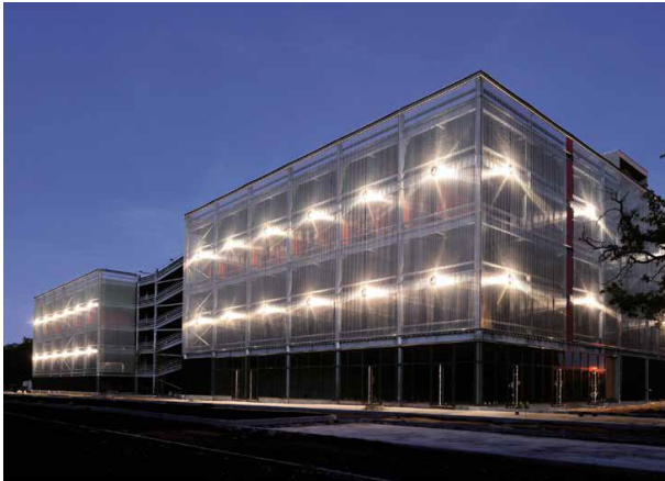
Figura 16. Aparcamiento Terre Sud, Bègles, Francia, ventilación e iluminación naturales que brinda la malla para arquitectura de HAVER Fuente: Haver & Boecker, 2020
