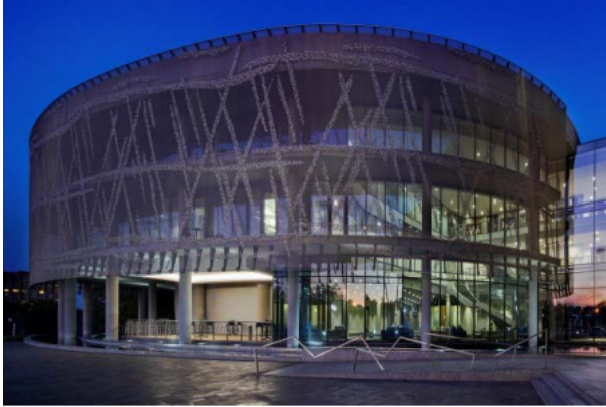
Figura 31. Fachada del edificio the drum is caling, con el panel metálico de protección.
