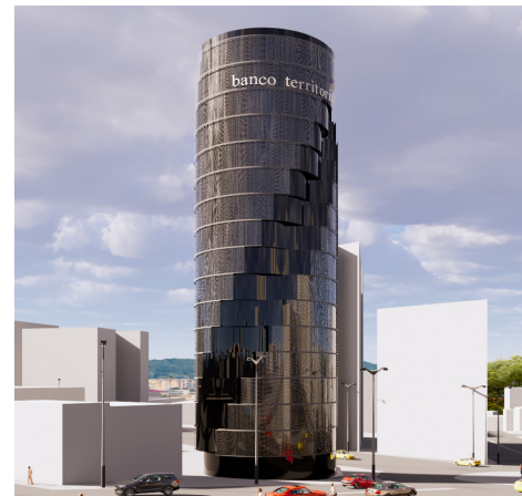
Figura 71. Prototipo 3D con sistema de protección solar
