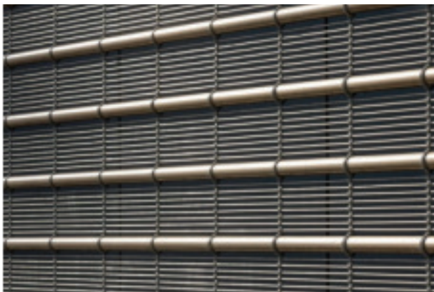
Figura 30. Vista cercana del panel de protección solar de HAVER Fuente: aver & Boecker, 2020
