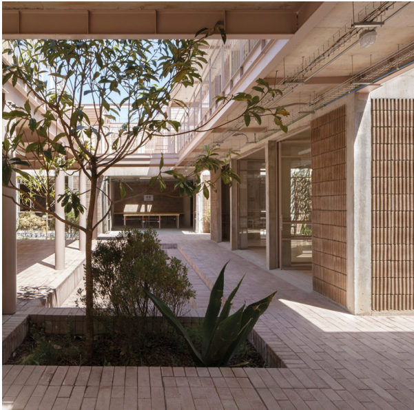
Fig. 21: Zona social PILARES Fuente: Rozana Montiel, 2021
