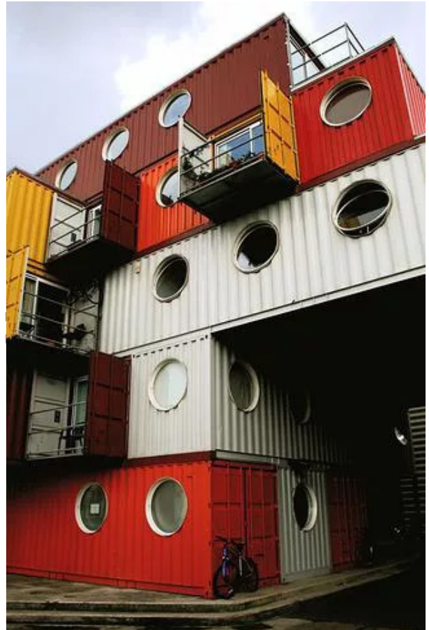
Fig.34. Edificación con containers Fuente: Andres Caguana (2008)
