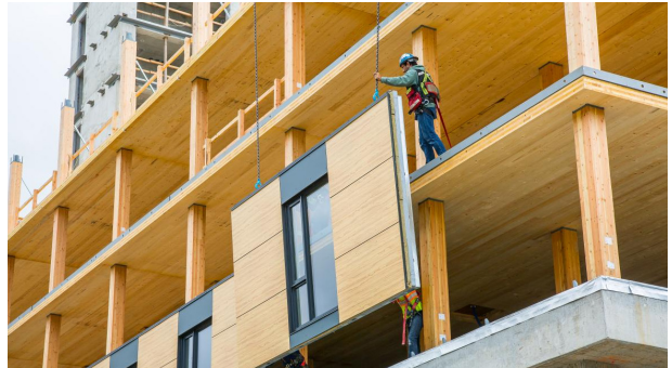
Fig.31. Diseño estructural UBC Tall Wood Fuente: Arq. Acton Ostry (2017)
