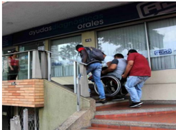
Fig. 1. Falta de accesibilidad para personas con discapacidad.
