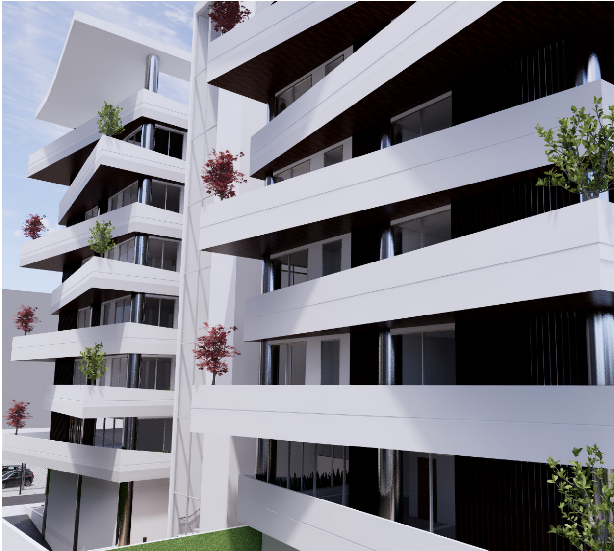
Fig. 99. Fachada Frontal. Fuente. 99. Elaboración Propia, 2022.
