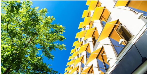
Fig. 15 Representación de parasoles en las fachadas de las edificaciones Fuente: Chunyip Wong, (2019).
