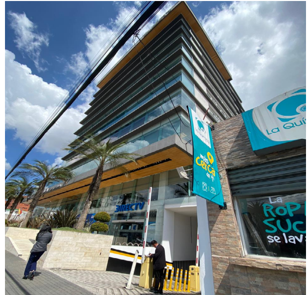
Fig. 37 Edificio Santa Fe corporativo.
