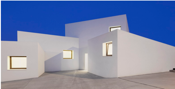
Fig. 19 Fachada posterior de vivienda MM del estudio OHLAB
