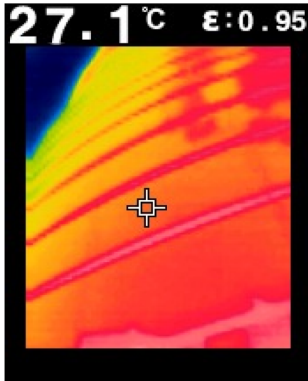
Fig. 56 Temperaturas de la edificación Santa Fe Corporativa Fuente: Pistola Térmica(2023).
