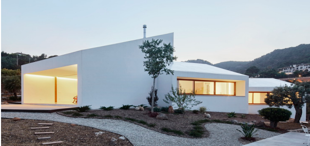
Fig. 21 Fachada lateral vivienda MMdel estudio OHLAB Fuente: OHLAB (2015).
