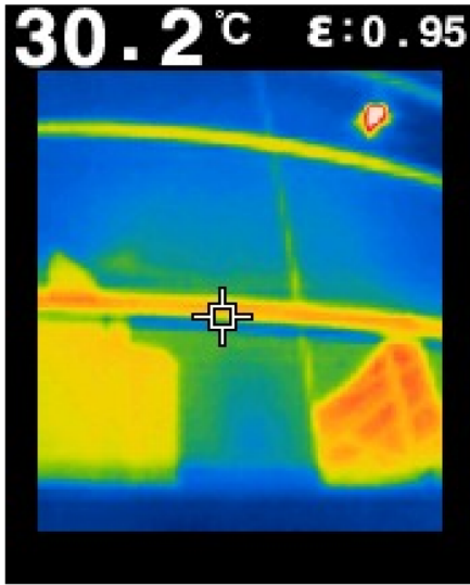
Fig. 54 Temperaturas de la edificación Santa Fe Corporativa Fuente: Pistola Térmica(2023).
