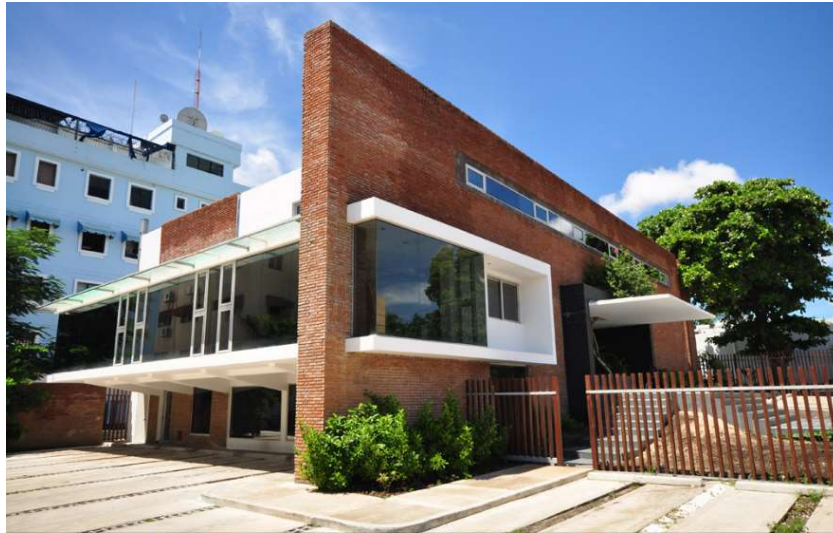
Imagen 16 Vista principal Edificio Administrativo Grupo Banas Fuente: http://www.danielpons.do
