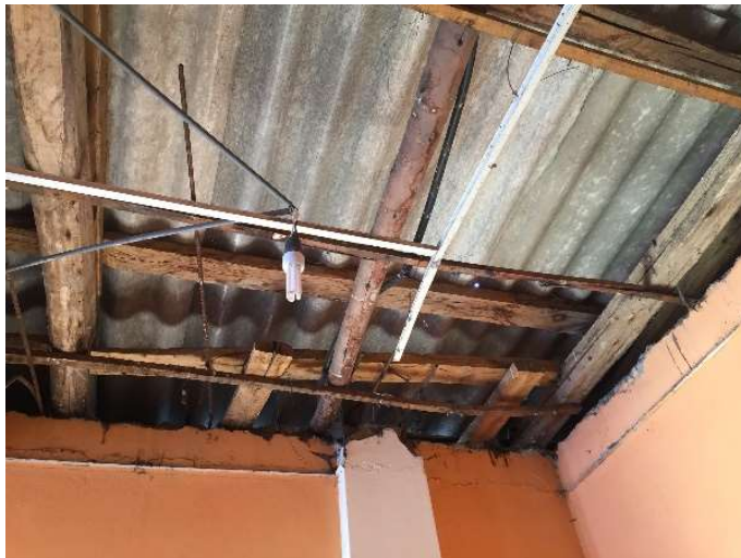
Fotografía 6 Vista del estado actual del techo
