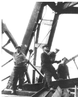
Imagen 4 Estructura de acero
