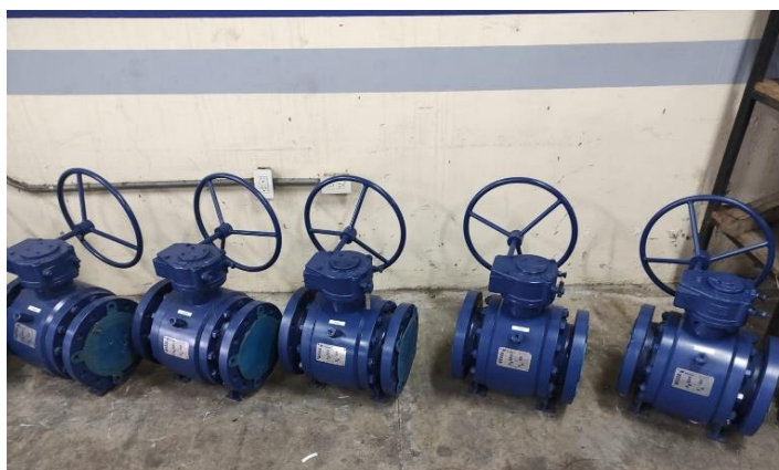
Imagen 12. Válvula luego de limpieza y desinfección
