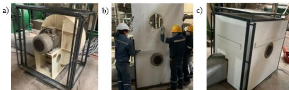
Figura 17: Paredes de la cámara acústica.
