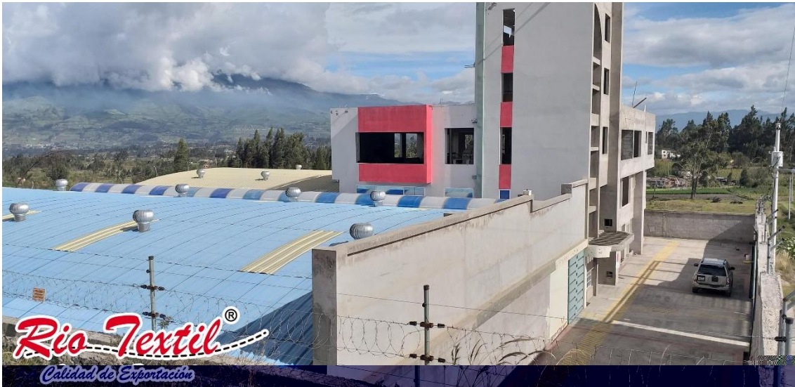
Imagen 1 Instalaciones actuales empresa Rio Textil
