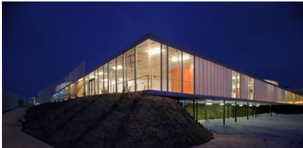
FIGURA 8 Fachada principal de Centro Geriátrico Santa Rita en Ciudadela, Menorca
