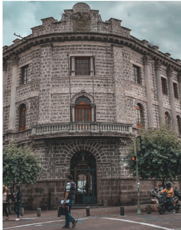
Nota: Fotografía de la Fachada Frontal de La Gobernación de Tungurahua
