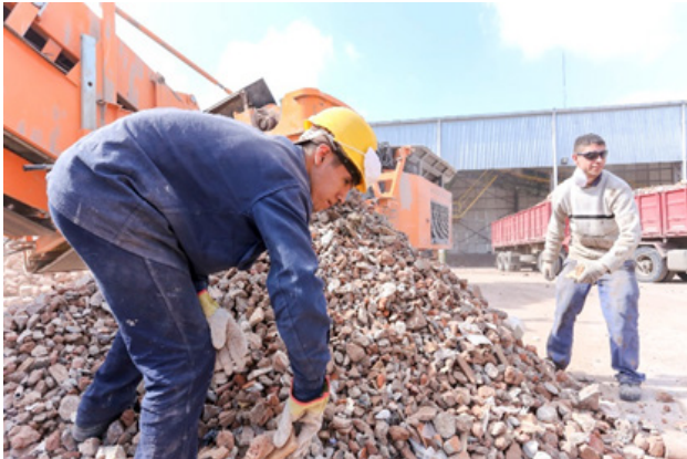
Figura 38 Trituradora de hormigón.
