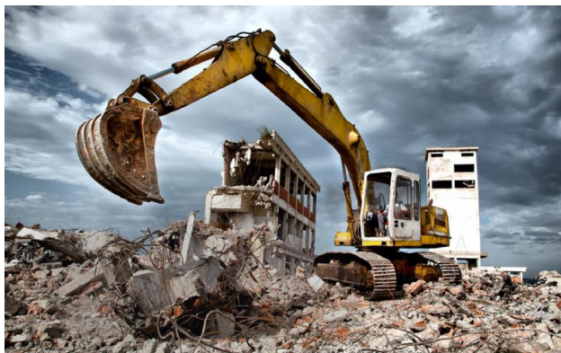
Figura 11 Demolición de estructuras.
