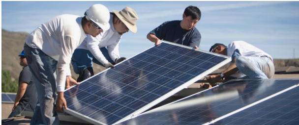
Figura 68. Fijación de placas solares Fuente: Autosolar,2021
