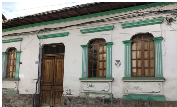
Figura 11. Ventanales de la Casona Universitaria-UTI.
