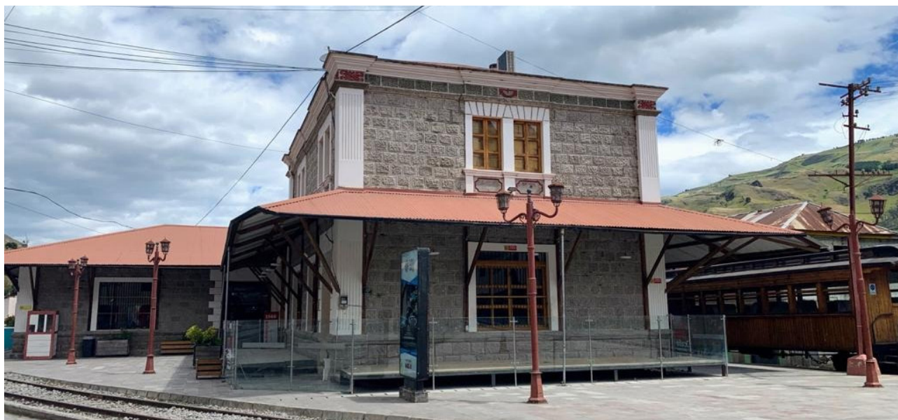
Figura 3. Estación Ferroviaria de Alausí
