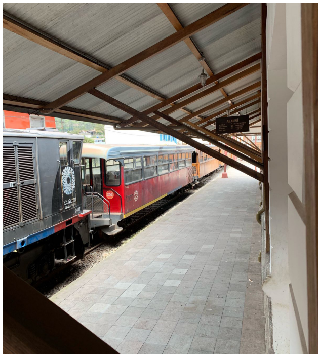
Figura 5. Andén estación ferroviaria de Alausí
