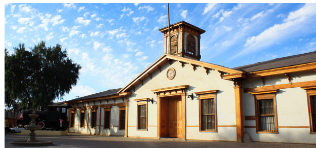
Figura 2. Estación del Ferrocarril de Copiapó
