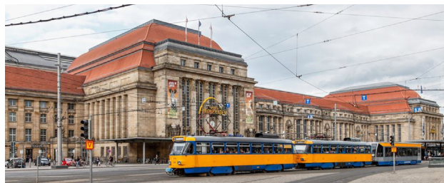
Figura 1. Estación Ferroviaria de Leipzig
