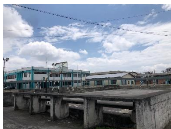
Cancha de futbol de cemento
