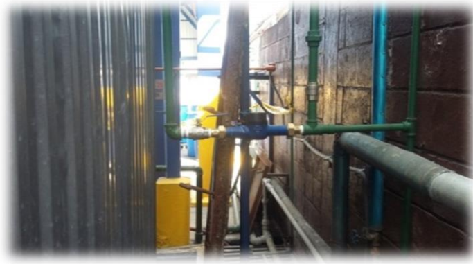
Gráfico 27: Instalación de medidor de caudal.
