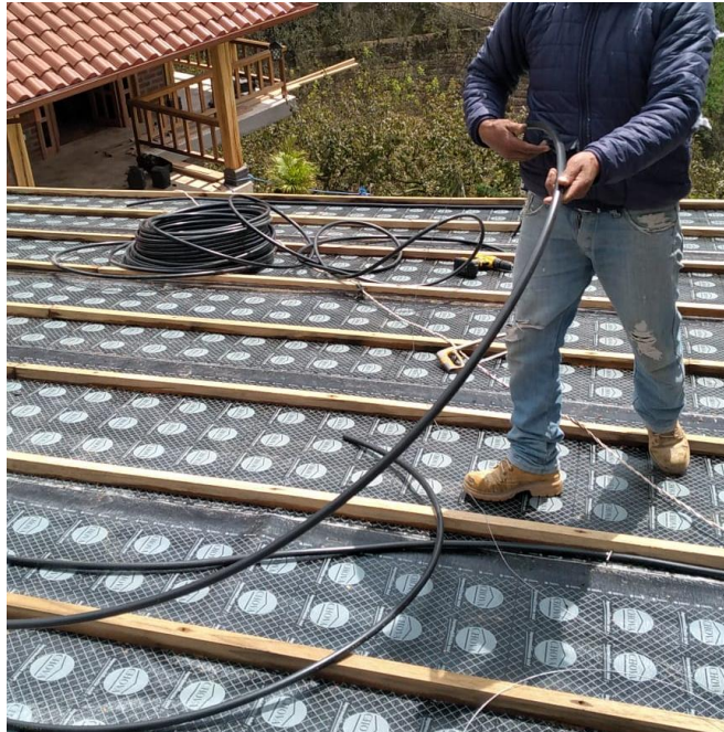
Ilustración 6. Tendido de mangueras y alambrado eléctrico Elaborador por: Palacios (2022)
