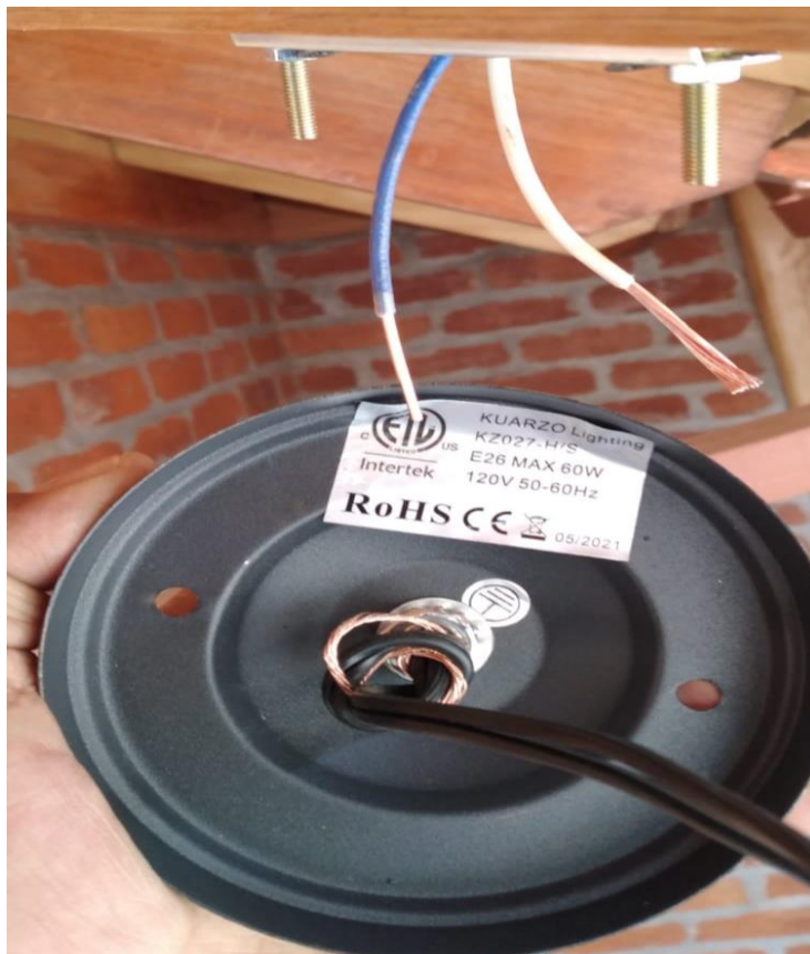
Ilustración 5. Tubería con pasacables Elaborado por: Palacios (2022)
