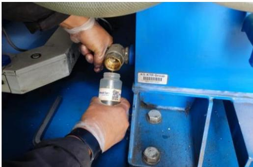
**Imagen 5** Muestreo tomado de válvula muestreador.
