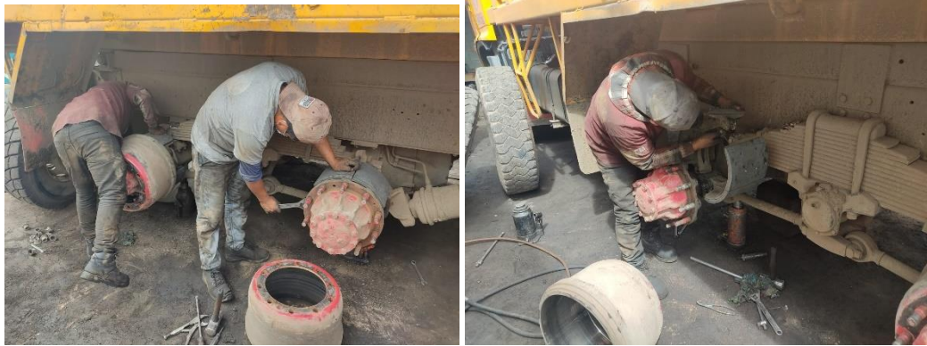
Imagen 6: Desmontaje de llantas para limpieza y cambio de pastillas. Elaborado por: Zúñiga, Cristian (2022)
