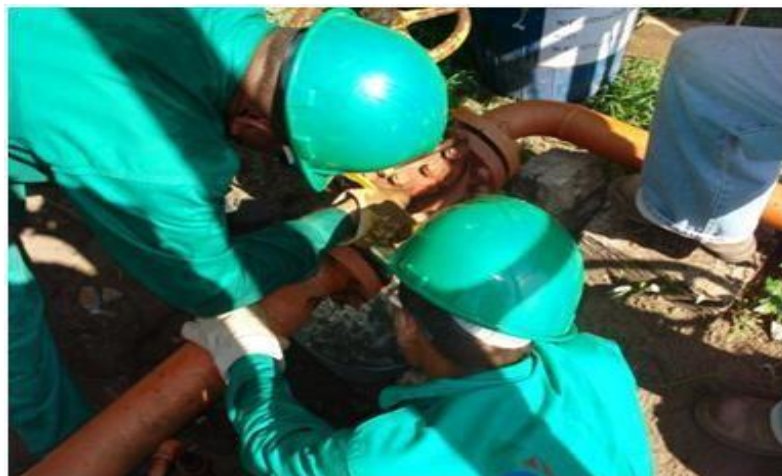
Imagen N° 6: Prueba hidrostática Fuente: CPP (2022)
