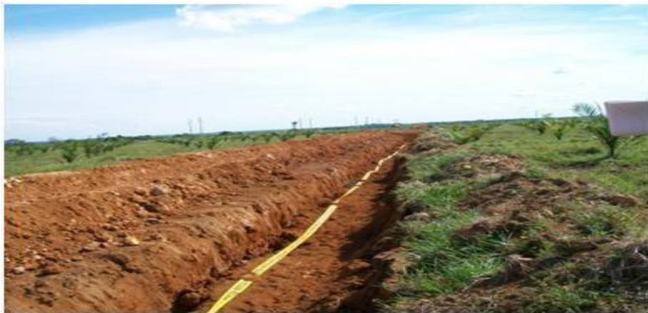
Imagen N° 3: Excavación de la zanja Fuente: CPP (2022)
