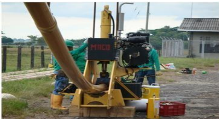
Imagen N° 4: Doblado de la tubería Fuente: CPP (2022)
