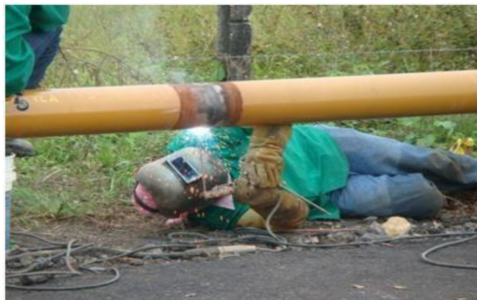
Imagen N° 5: Soldadura de la tubería
