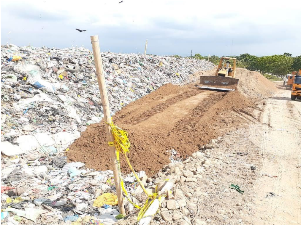
Gráfico 24: proceso de almacenamiento y cubierta con arcilla de desechos sólidos para su descomposición
