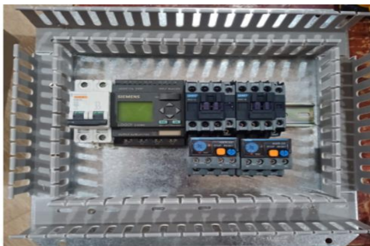
Imagen 8. Armado de tablero de control. Elaborado por: Luis Mejía Fiallos, (2022).
