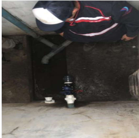
Imagen 20. Prueba de electroválvulas. Elaborado por: Luis Mejía Fiallos, (2022).
