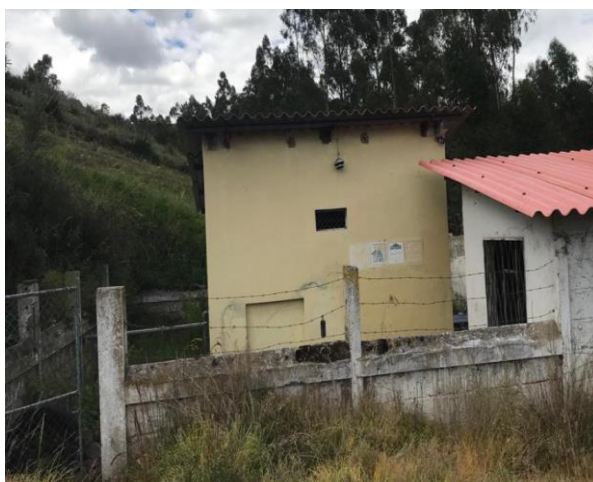
Imagen 3. Sistema de bombeo. Elaborado por: Luis Mejía Fiallos, (2022).
