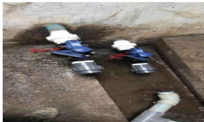
Imagen 19. Adaptación de las electroválvulas a los ramales. Elaborado por: Luis Mejía Fiallos, (2022).
