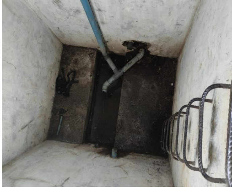
Imagen 18. Instalación de las electroválvulas. Elaborado por: Luis Mejía Fiallos, (2022).
